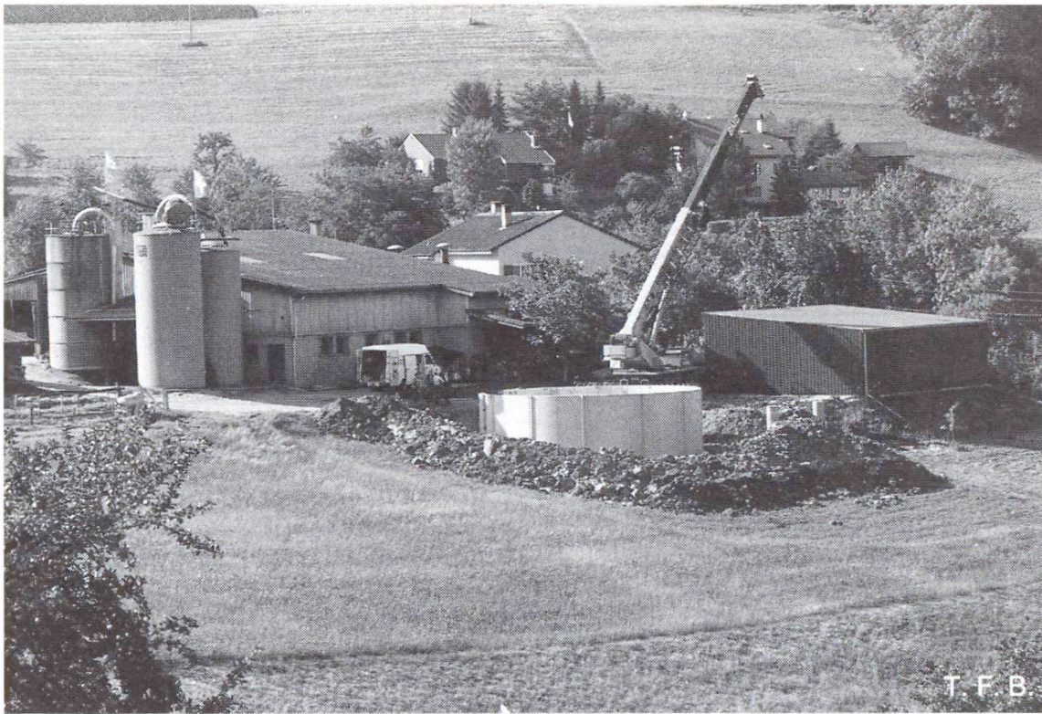
Abb. 14 Güllebehälter nach Montage der Elemente. Hinterfüllen mit Aushub und Gestalten der Böschung zur Abrundung der Hofanlage. Anbringen eines Schutzzaunes, sofern Behälterwand nicht mehr als 1 m über Terrain führt (Buckten, Kanton Baselland).
