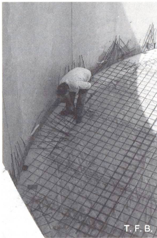
Abb. 11 Armieren der Bodenplatte, anschliessend Betonieren und Vorspannen der Wände.
