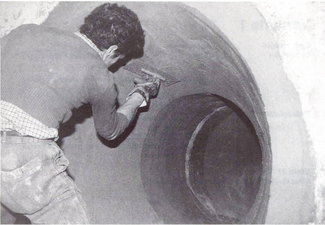
Abb. 7 Aufbringen einer Zementmörtelauskleidung.
