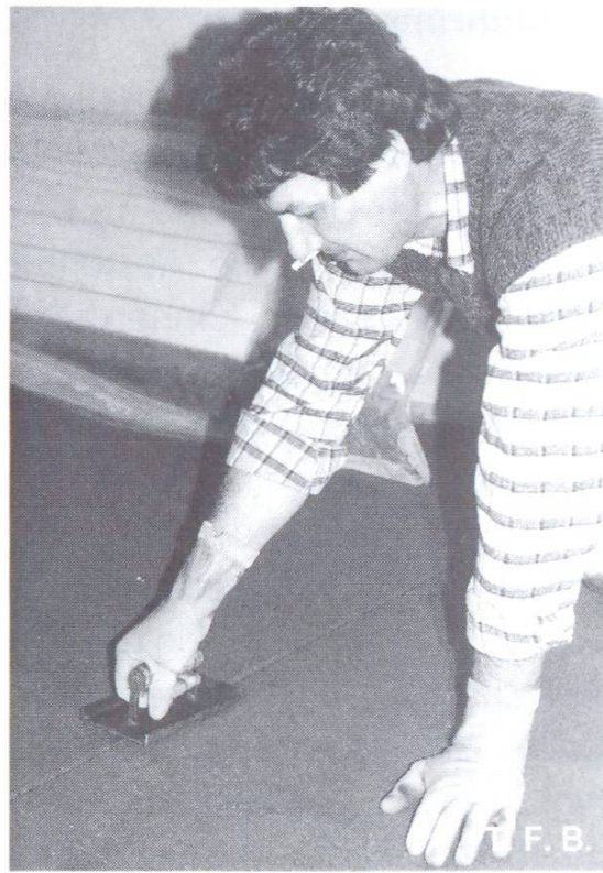
Abb. 5 Erstellen einer Schwindfuge mit dem Fugeneisen. Der Unterlagsboden wird nicht ganz durchgetrennt.
