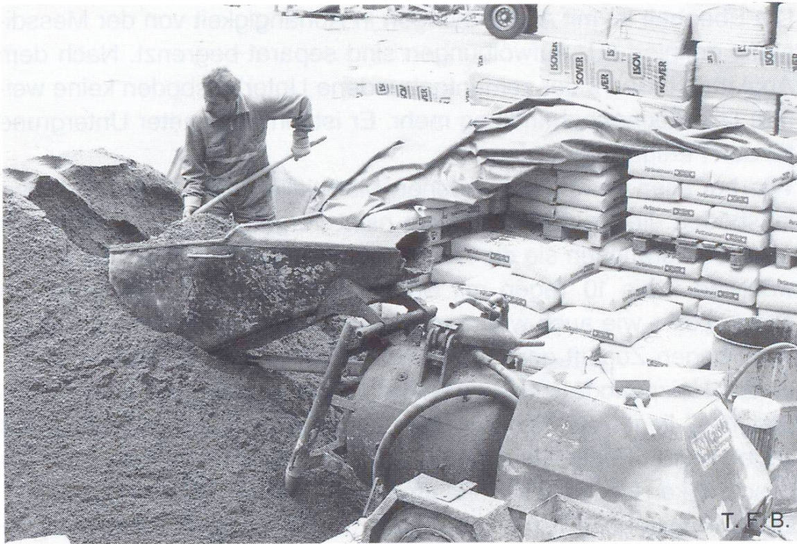
Abb. 2 Mischen des Mörtels und Pumpen zur Einbaustelle
