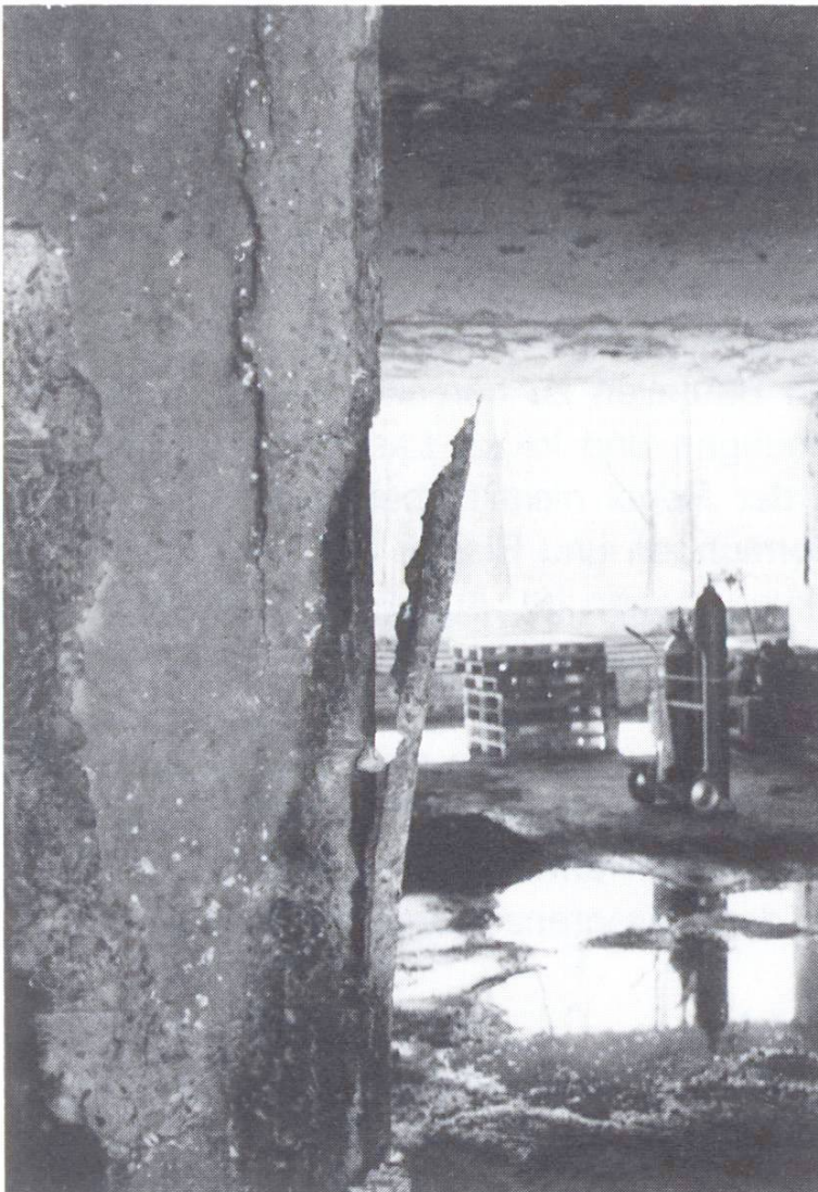
Abb. 4. Abplatzungen an einer brandgeschädigten Stütze.
