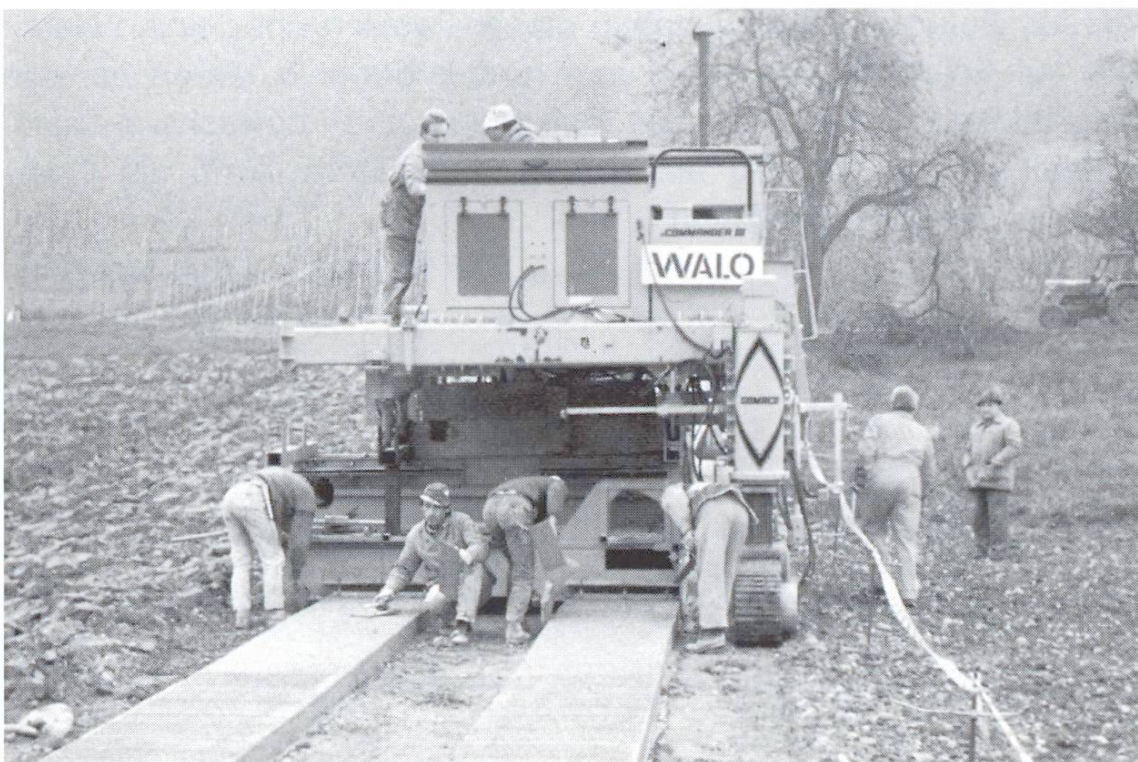
Moderne Gleitschalungsfertiger erleichtern den Bau von Betonspurwegen.
