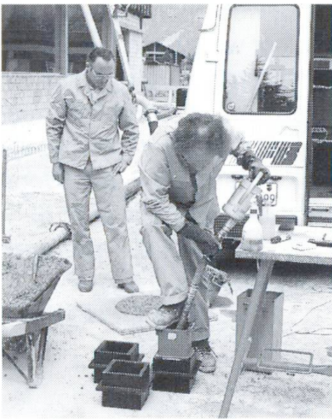
Verdichten des Betons mittels eines Vibrators.
