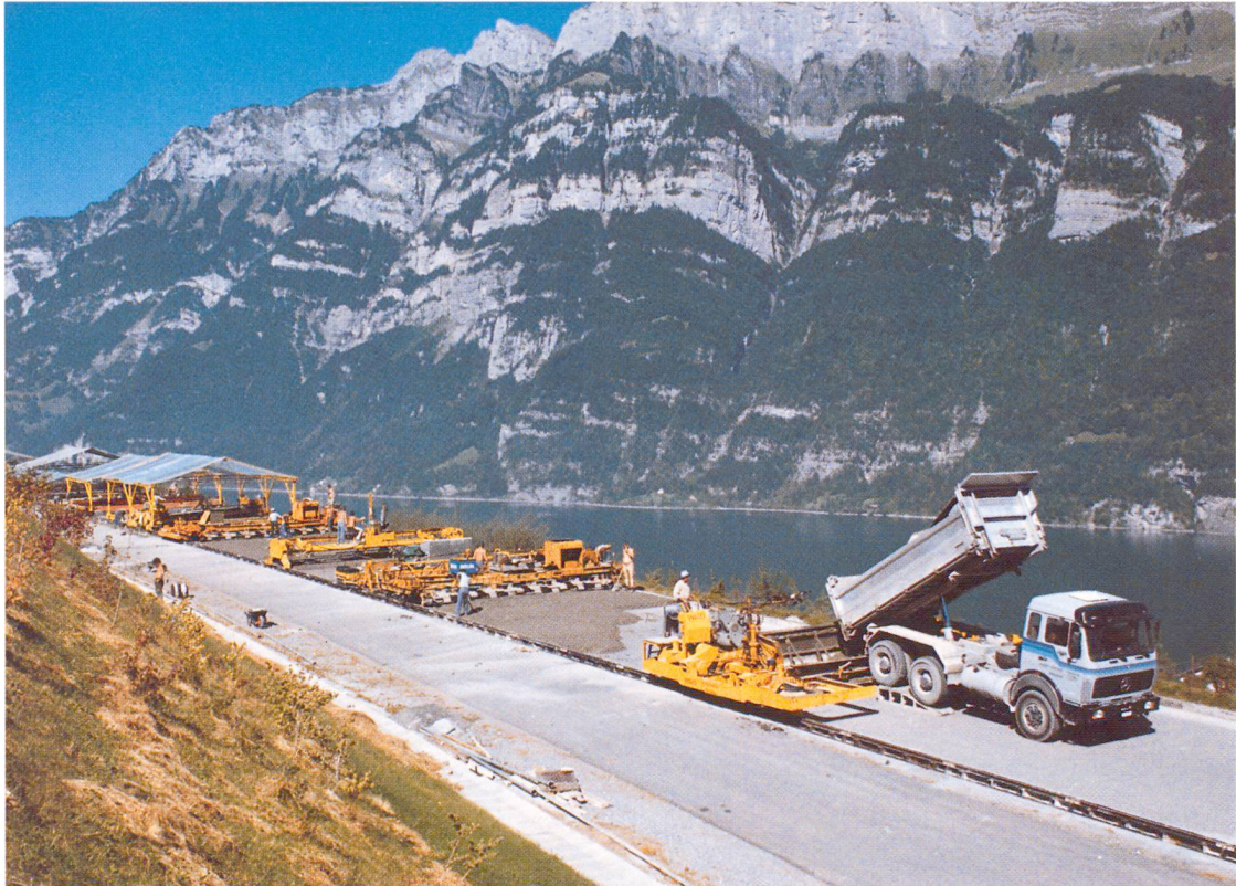
Schienen- einbauzug auf der Walensee- autobahn (N3).
