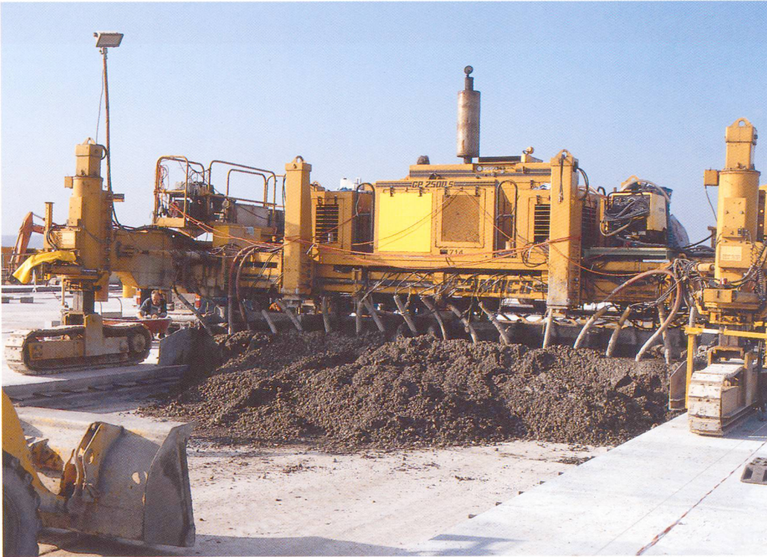
Einbau mit Gleitschalungs- fertiger.
