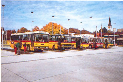
Oben: Lukmanierpassstrasse (erbaut 1965). Unten: Bushaltestelle beim Bahnhof Wil SG.
