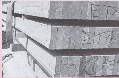
Brettstapelelemente mit Detail des Elementstosses.
