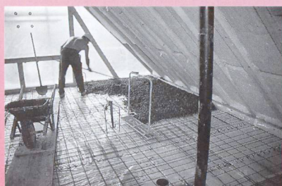
Betonieren mit einfachen Mitteln beim Umbau des Pfarrhauses Bassersdorf.
