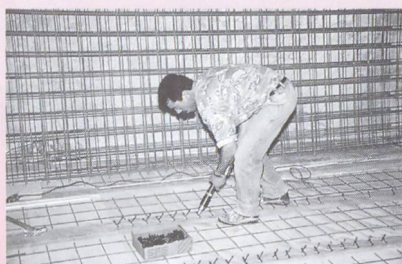
Einreihige, paarweise Anordnung der Verbundelemente im Rahmen eines Umbaus.
