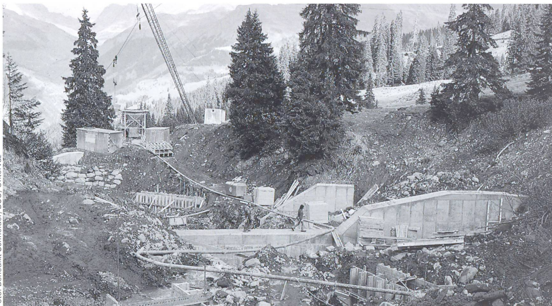
Bachverbauung: Pumpbeton- förderung in un- wegsamem Gelände.
