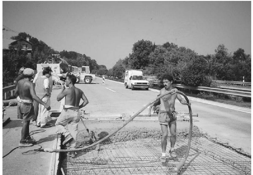
Teilersatz einer Betonplatte (A1).
