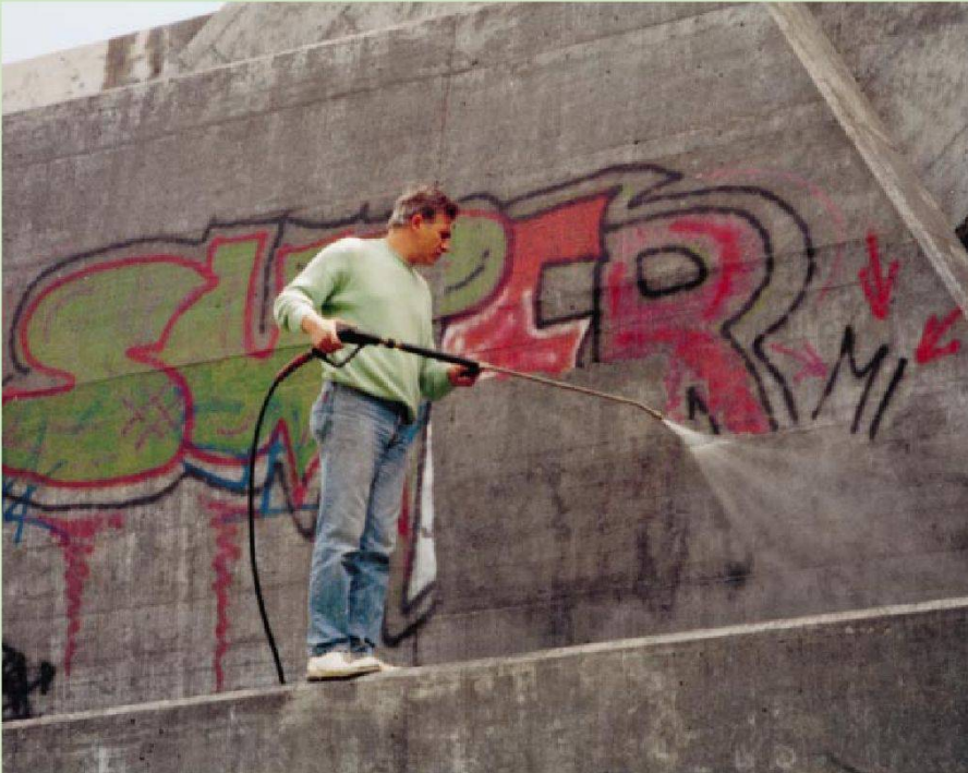
Entfernung von Graffiti auf Sichtbeton, der mit einer Imprägnierung und einer Wachsschicht (Opferschicht) vorbehandelt war.
