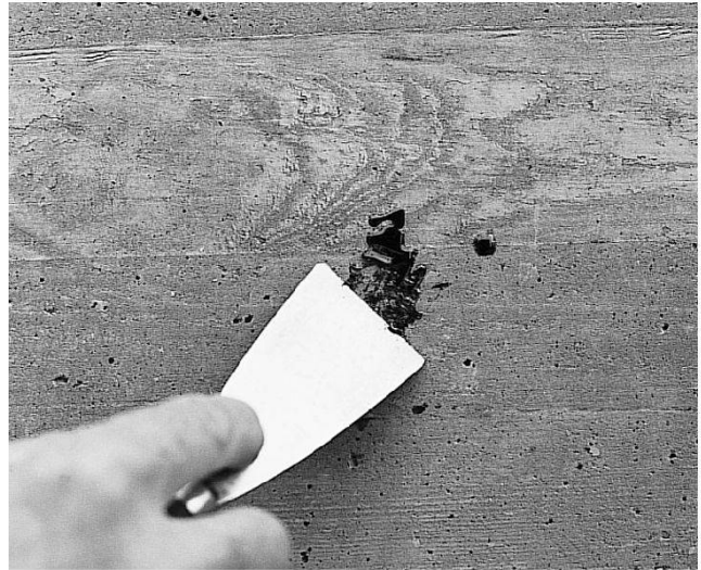
Abb. 2 Mit dem Spatel wird möglichst viel Fremdmaterial entfernt.
