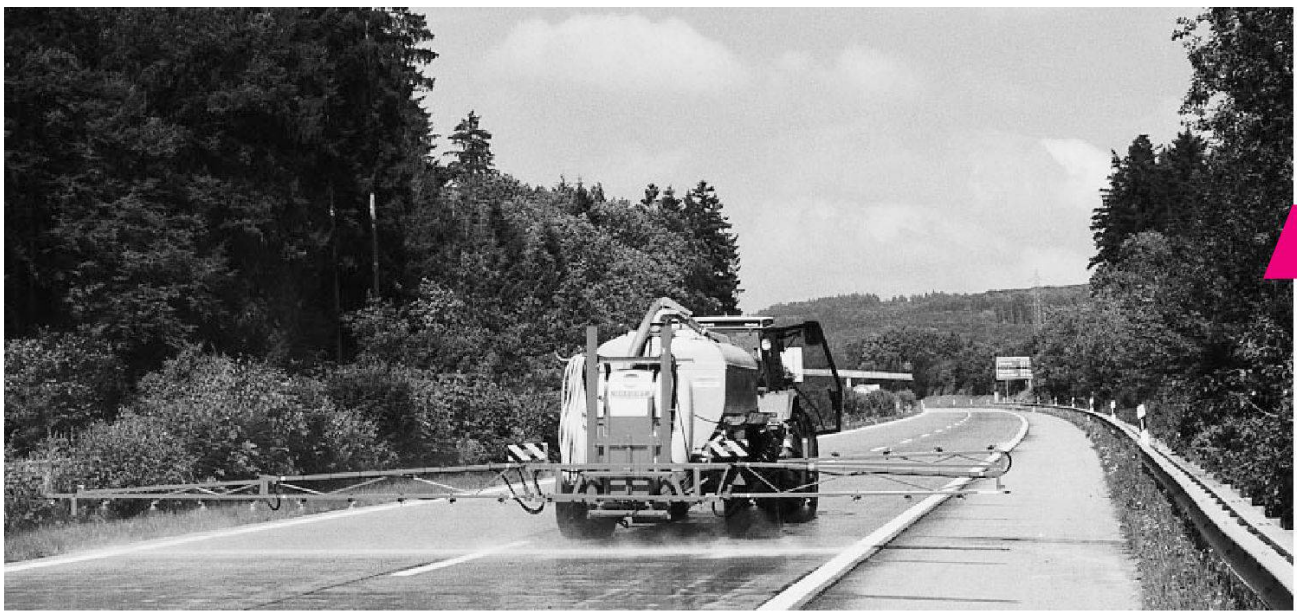
Hydrophobierung einer Betonfahrbahn.
