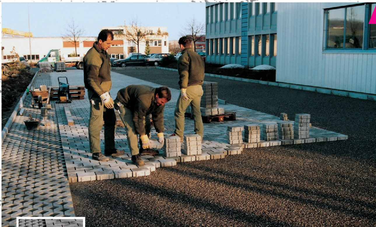
Handverlegung von Betonpflastersteinen.
