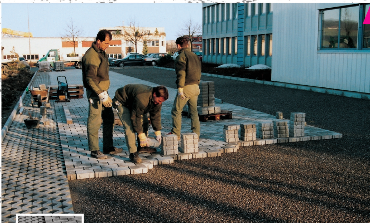
Handverlegung von Betonpflastersteinen.
