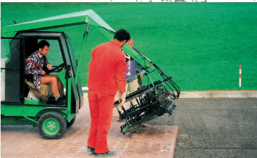
Mit Verlegemaschinen lassen sich Betonpflastersteine direkt ab Palette verlegen.
