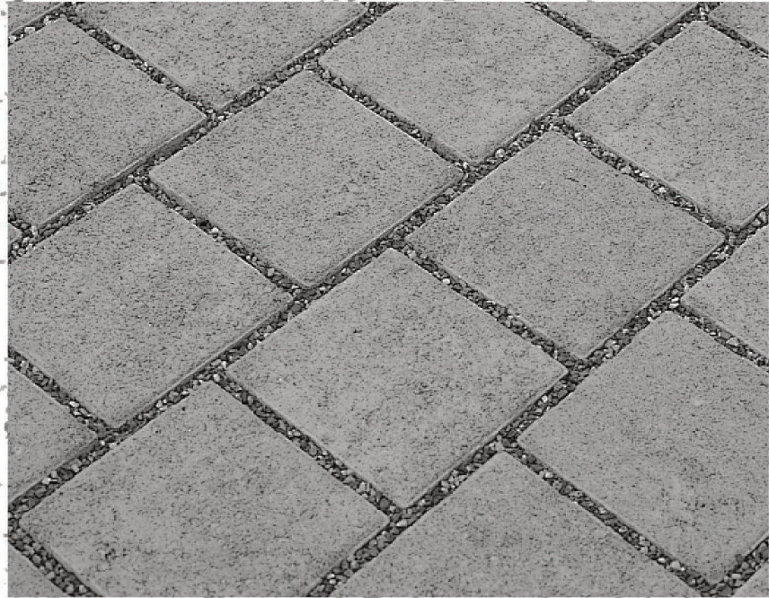
Wasserdurchlässiger Pflasterbelag mit Splittfugen.
