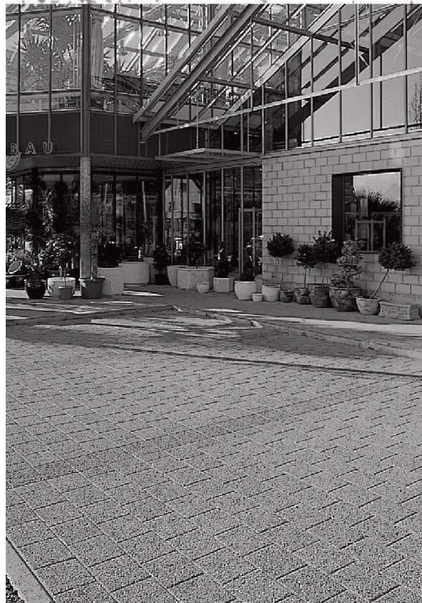
Wasser- und luftdurchlässige Sickersteine in wenig befahrenem Bereich.
