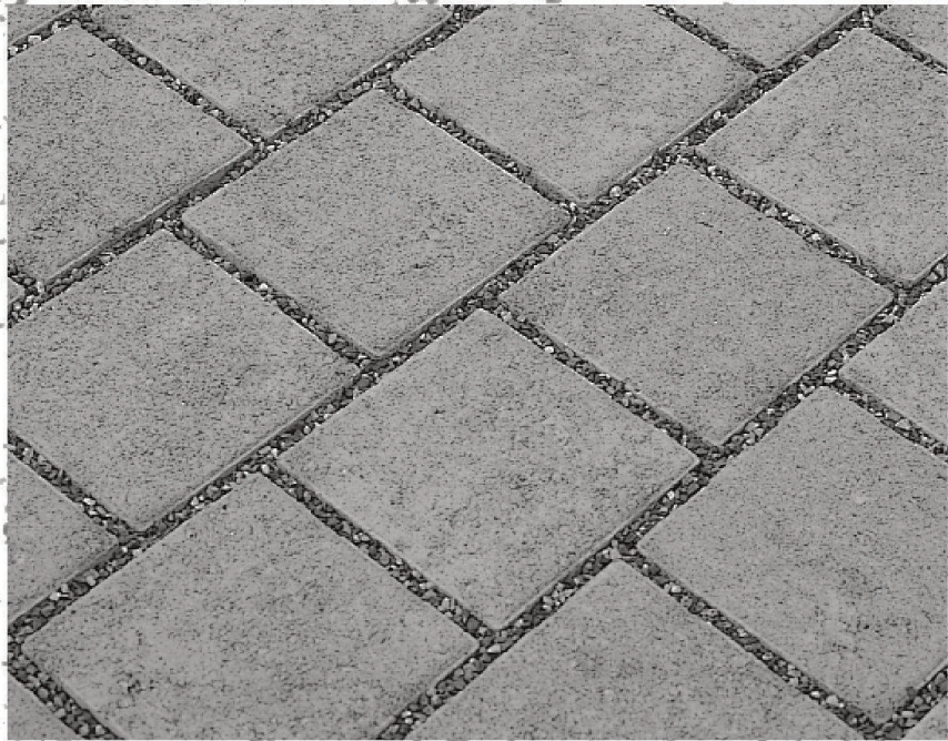
Wasserdurchlässiger Pflasterbelag mit Splittfugen.
