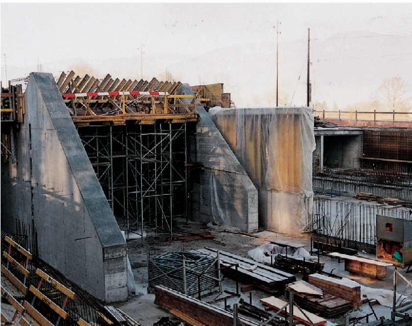
Tagbautunnel Lüsslingen (A 5): Anwendung von CEM II/A-L 32,5 R.
