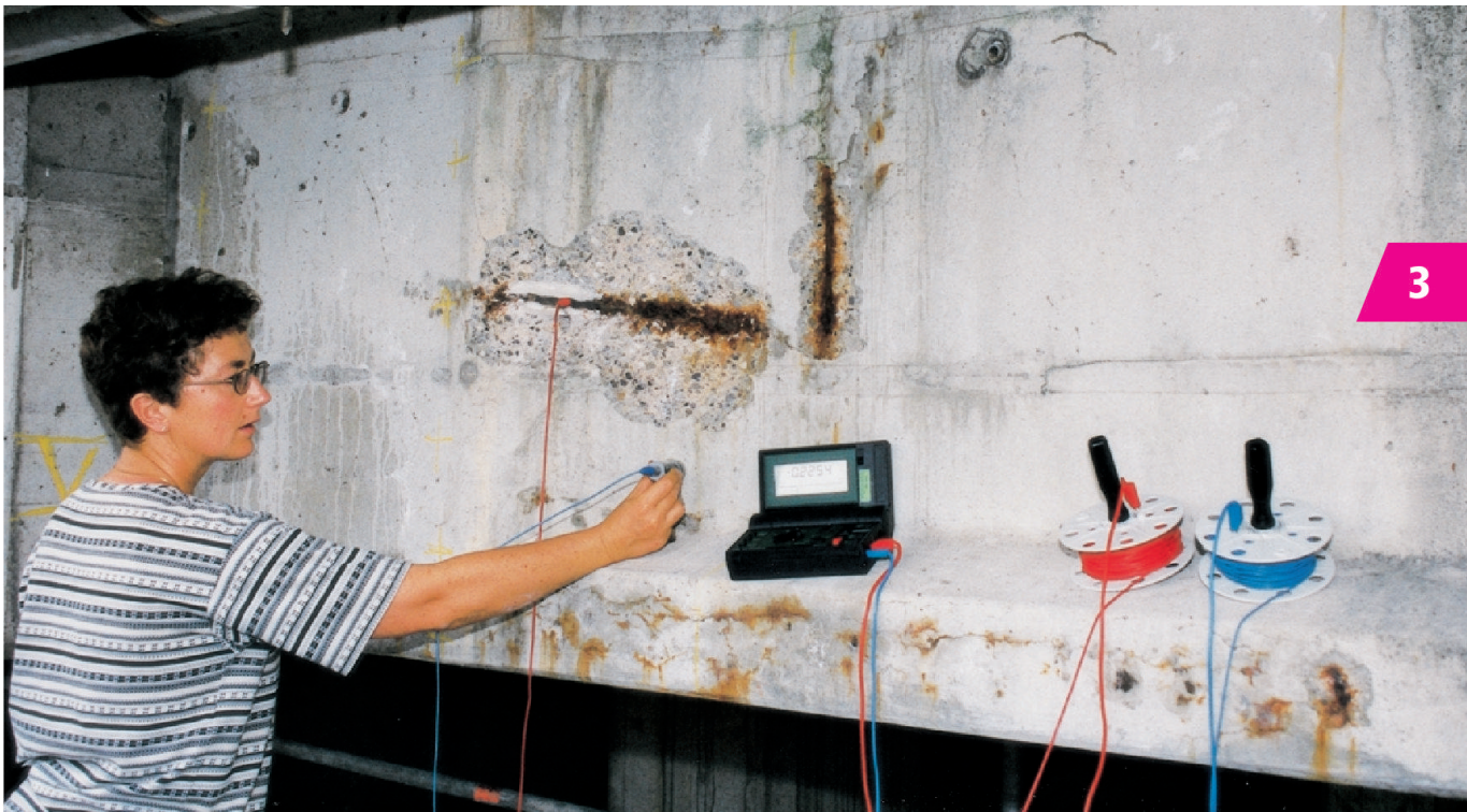
Potentialmessung an Brückenunterseite.
