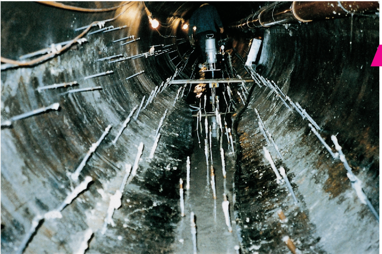
Im Boden-/Sohlenbereich einer Betonkanalisation gesetzte Packer.
