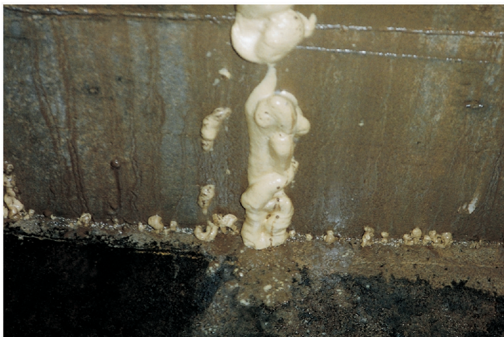
Wasserstop durch PUR-Injektion.
