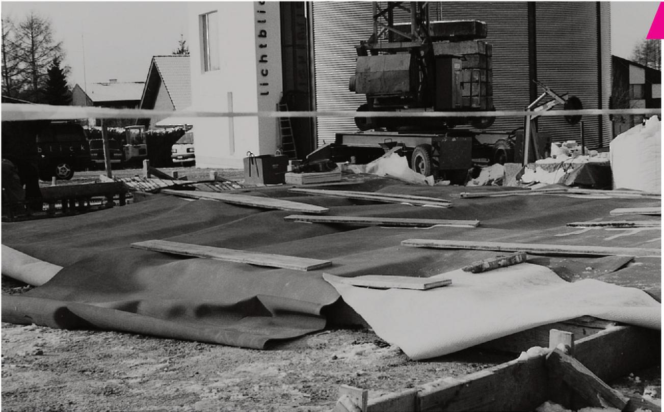
Vor Kälte und Luftzug geschützte frisch betonierte Bodenplatte.
