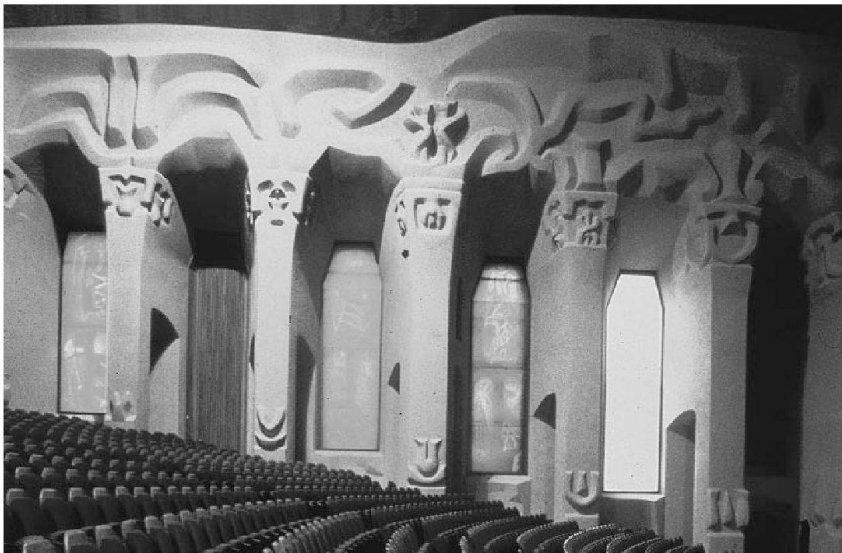
Abb. 12 Nordwand des grossen Saals. Die geschliffenen Glasfenster stammen aus den Dreissigerjahren.
