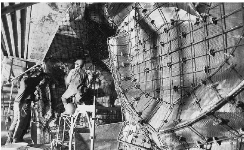
Abb. 6 Zum Spritzen bereit: Streckmetall als «verlorene Schalung» hinter dem Rundstahlskelett.
