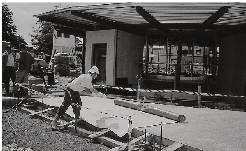
Abdecken eines frisch eingebauten Betonbelags mit Thermomatten.
