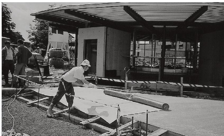
Abdecken eines frisch eingebauten Betonbelags mit Thermomatten.
