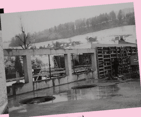
SCC-Sichtbeton (Raum Luzern)
