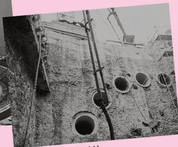
Rohrschirm aus SCC (Zürich)
