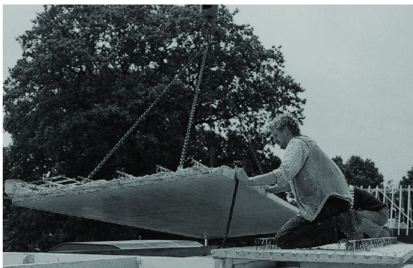
Abb. 1 Verlegen einer Elementdecke.
