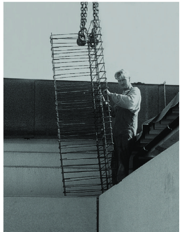
Abb. 9 Einsetzen des Bewehrungskorbs im Eckbereich der Dreifachwände.
