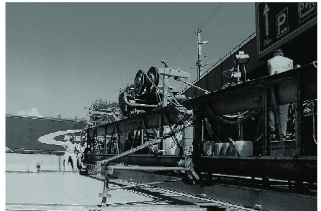
Abb. 5 Mit dem Längsglätter am zweiten Gleitschalungsfertiger wird die Ebenheit des Oberbetons optimiert.
