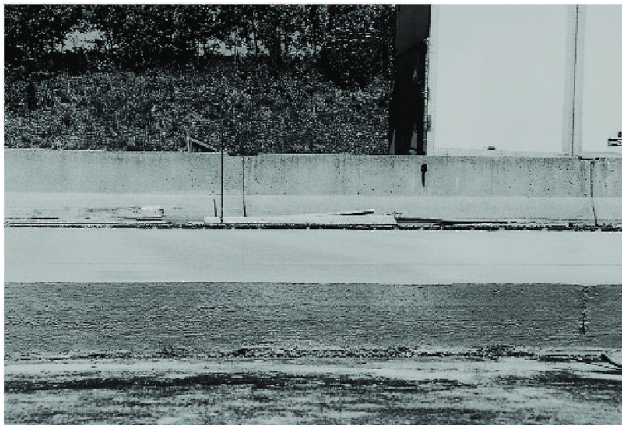
Abb. 8 Perfekt «stehende» Betonkante unmittelbar nach dem zweiten Gleitschalungsfertiger.
