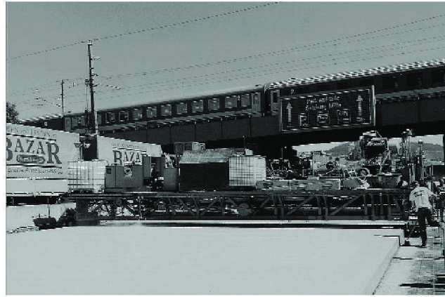
Abb. 7 Auch Engpässe können mit dem Gleitschalungsfertiger problemlos durchfahren werden.
