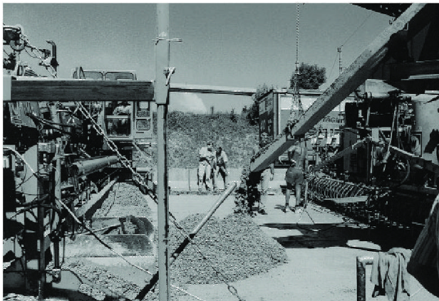
Abb. 4 Über ein Förderband, das über dem Unterbeton-Gleitschalungsfertiger montiert ist, wird der Beton für den Oberbeton-Gleitschalungsfertiger (links) antransportiert.
