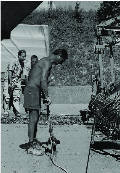
Abb. 2 Einvibrieren eines Ankers in der Mittellängsfuge unter kritischen Schweizer Augen.
