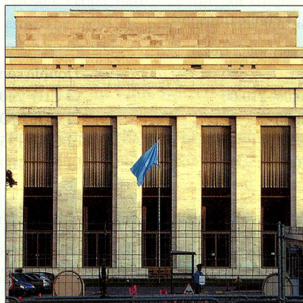
The UN building in Geneva.
