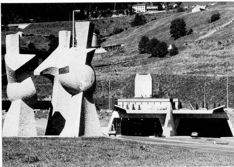
Vue de l'entrée du tunnel, côté tessinois
