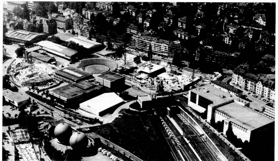
En raison d'importants travaux de construction, les organisateurs de l'OLMA, la grande foire suisse de l'agriculture qui se tient à Saint-Gall, ont dû trouver cette année, du 8 au 18 octobre, des solutions provisoires. (Photo: Foto Gross/Service de presse OLMA).
