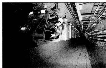
Vue partielle du tunnel du LEP avec un monorail pour le transport des personnes et du matériel.
