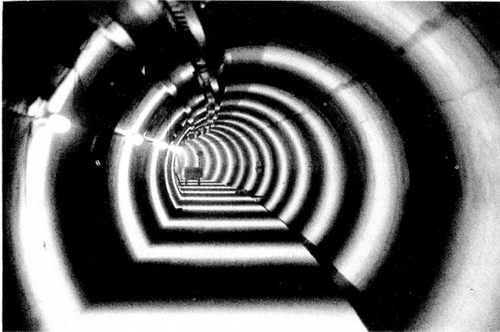
Pour l'accélérateur de particules LEP, on a construit un tunnel circulaire de 27 kilomètres de circonférence. Le tunnel a un diamètre de 3,8 mètres. (Photos: Cern)
