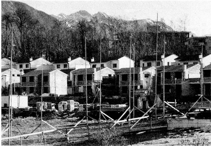
Un des multiples exemples pour une «thésaurisation» du terrain à bâtir à but spéculatif. L'introduction d'un délai d'interdiction pour une revente est en général considérée comme une mesure d'urgence adéquate. (Photo: Keystone)
