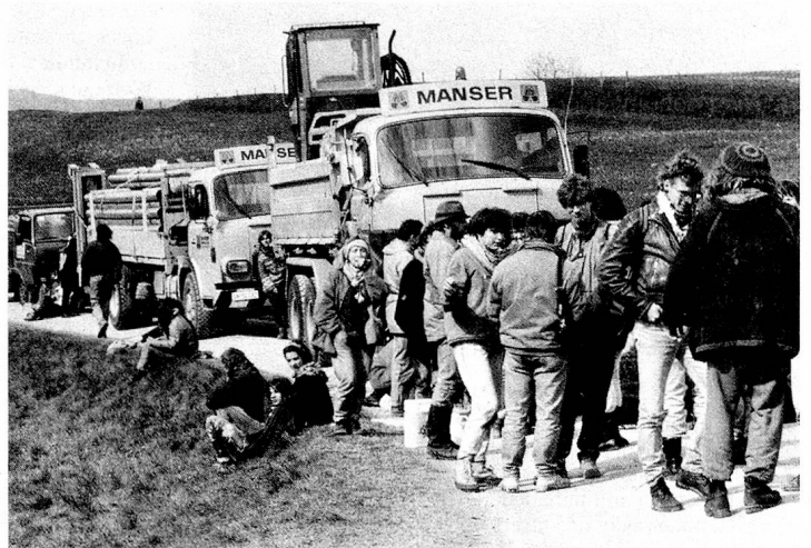
▼ Malgré l'occupation du terrain et des démonstrations, les travaux de construction pour la place d'armes de Neuchlen-Anschwilen (SG) ont commencé au début de l'été.
