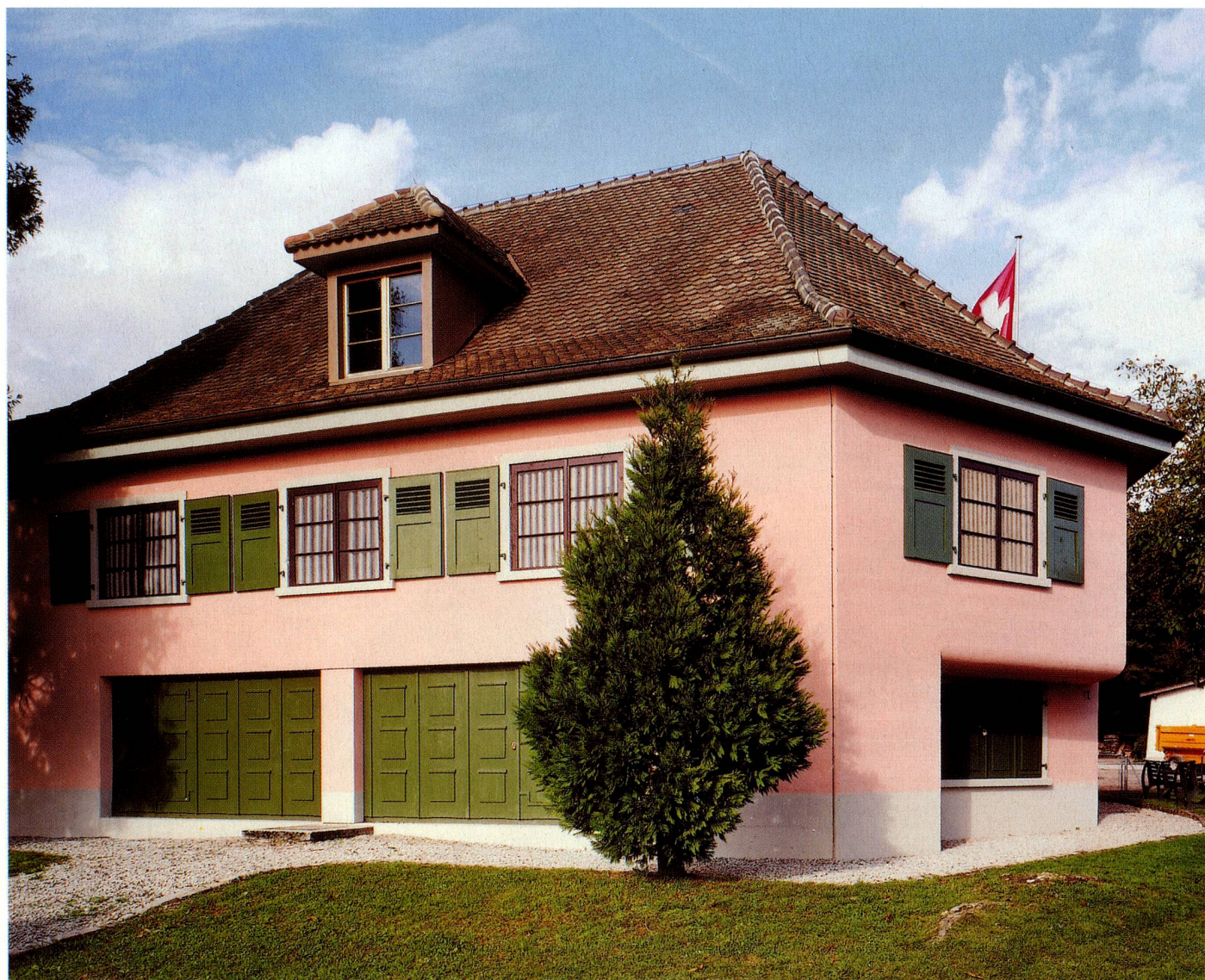
Villa, 1940, fortin d'infanterie, Gland (VD): construction massive à toit en croupe, avec lucarne et revêtement de tuiles. Derrière les fenêtres rapportées, rideaux peints directement sur le béton. Ce fortin sert aujourd'hui de musée.
