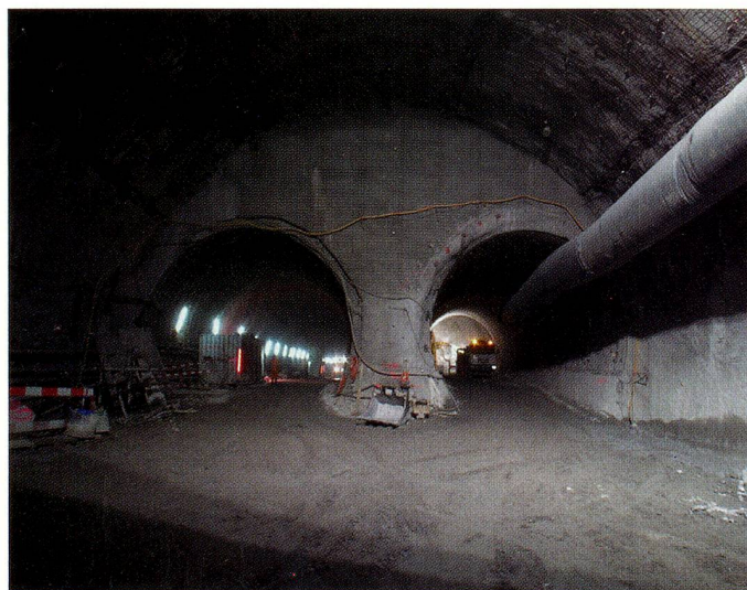
Le nouveau tunnel ferroviaire de base – 57 kilomètres – est le plus long du monde.
