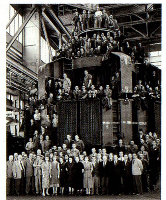
1952. Générateur vertical, fabriqué pour la centrale électrique du Nil à Assouan.
