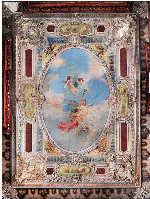
- Coupole en verre et peinture sur la façade extérieure - Galerie à l'étage - Hall d'entrée - Peinture dans la chambre de Madame (de g. à dr.)
