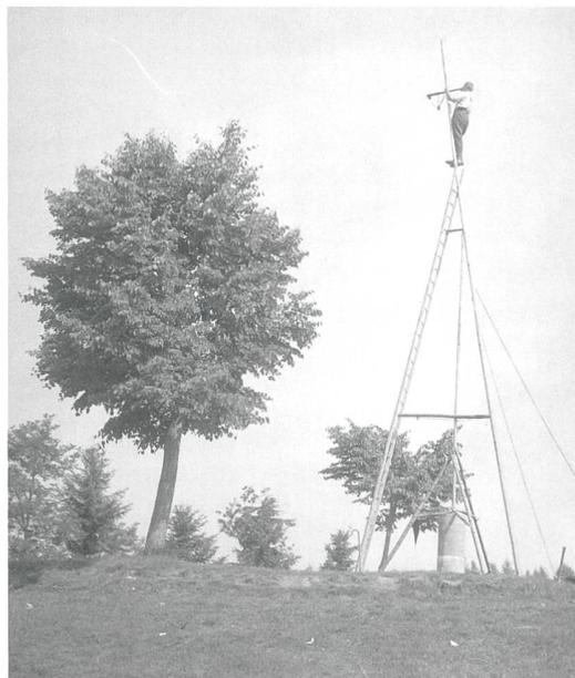
**Abb. 62:** Einfaches Leitergerüst zur Rekognosierung auf dem Triangulationspunkt 2. Ordnung Homberg nördlich von Reinach AG, 1909. Ingenieur Werner Lang (1885–1945) gelingt es, 18 m über dem Boden die Sicht nach der Gisliflue südlich von Thalheim sicherzustellen. Für die spätere Messung musste somit ein Beobachtungsturm gebaut werden. Glasplattennegativ 9x12 cm (swisstopo, Bildsammlung, technische Aufnahme 53, Inv. Nr. 000-389-695).
