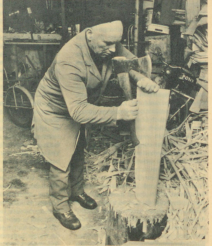
Mit dem Beil wird der Schindel der letzte Schliff gegeben: eine Arbeit, die viel Geschicklichkeit erfordert. (Photos: Comet, Zürich)
