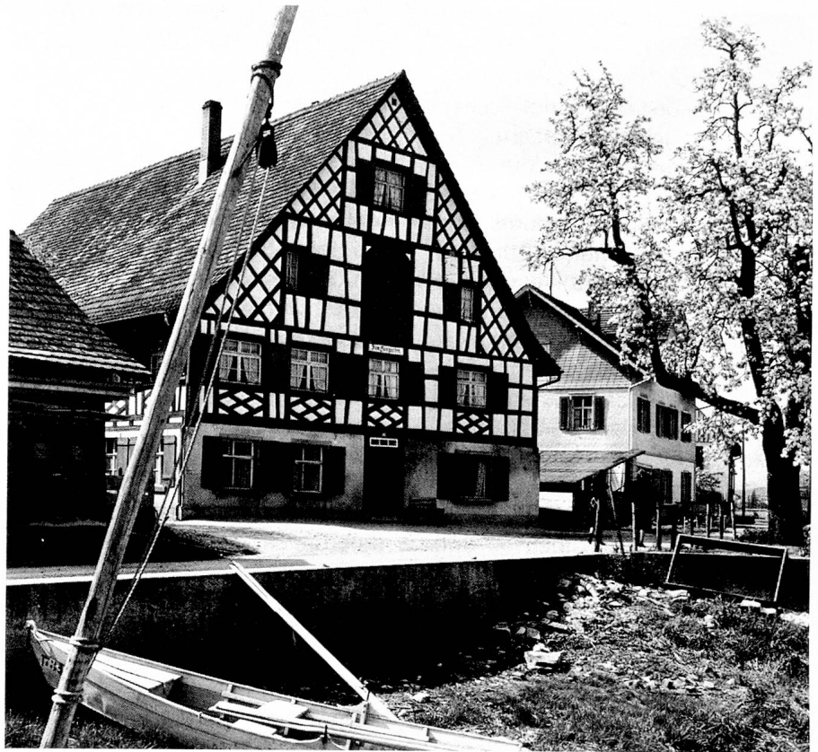
Riegelbau in Ermatingen
