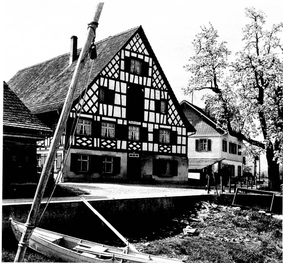
Riegelbau in Ermatingen
