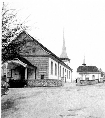
Restaurierung der barocken Kirche in Tafers (FR)
