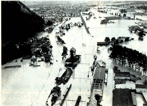
Unwetter: Luftansicht des überschwemmten Flüelens.
