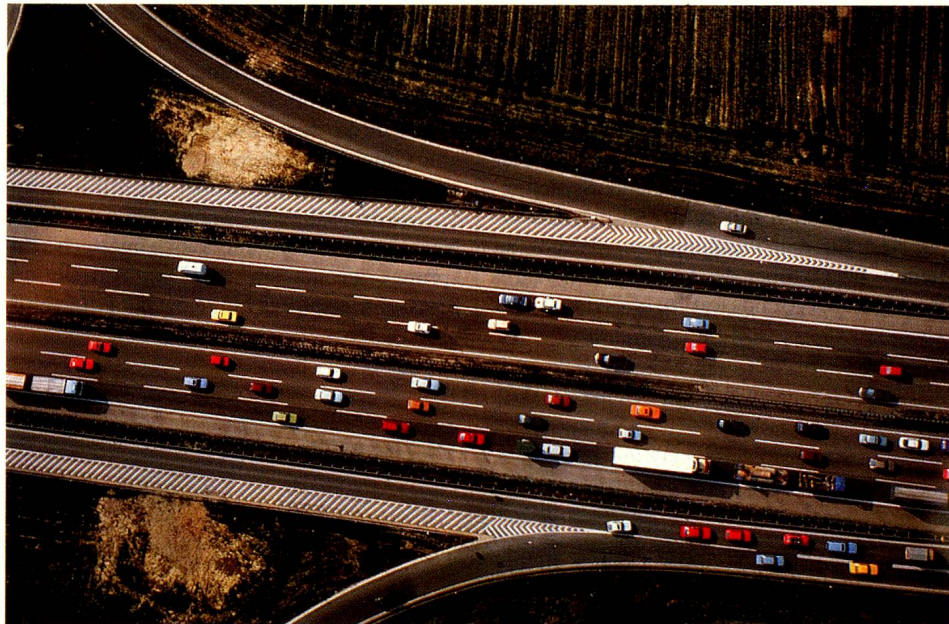
Autobahnen kanalisieren den Verkehr und sind erst noch 5x sicherer als Hauptstrassen. (Foto: Keycolor)
