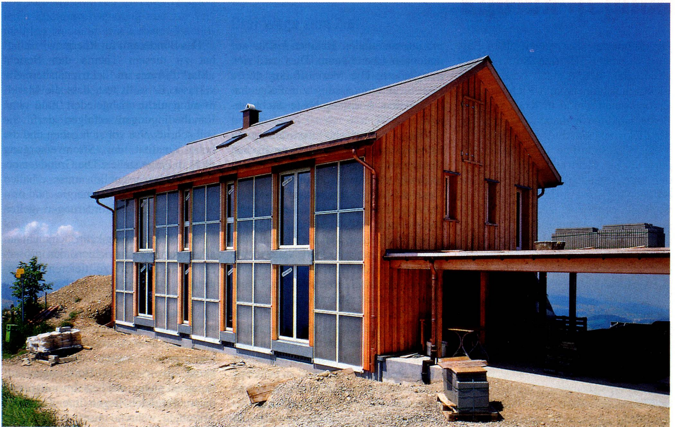
Ein Pilotprojekt im Kanton Appenzell: Hauswände werden durch die neue Technik der transparenten Wärmedämmung zu Sonnenenergie-Lieferanten. (Foto: Oerlikon Journalisten)
