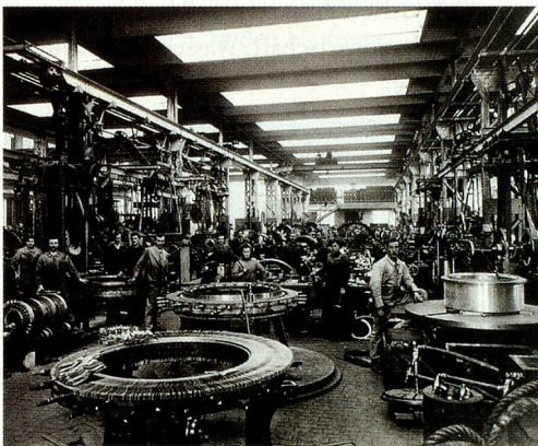
Um 1910 in der Wicklerei. Rechts ein Rotorteil in Bearbeitung.
