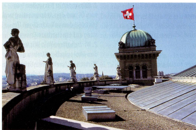
Auf dem Dach des Bundeshauses.
