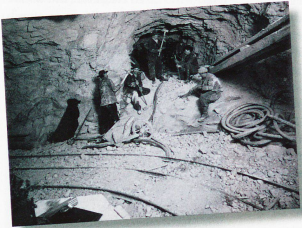
Mineure beim Tunnelbau kurz vor dem Durchstich auf dem Jungfrauoch am 21. Februar 1912
