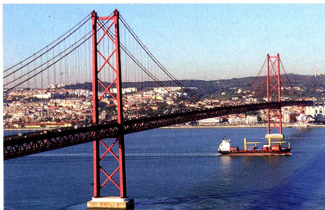
Wahrzeichen: Vasco da Gama, die Hängebrücke über den Tejo. Symbole: Vasco de Gama, le pont suspendu sur le Tejo.
