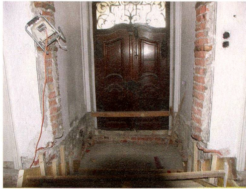
Holztür im Eingangsbereich
