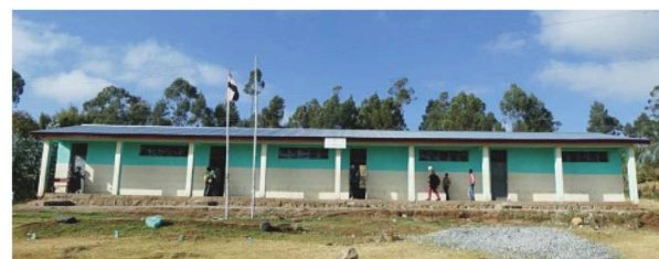
Fertiges Schulhaus 2016 mit 4 Klassenräumen zu 60 Plätzen
