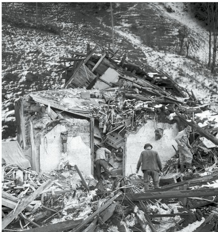
Nach Explosionen in den Kavernen prasselt Geröll aufs Dorf. Neun Menschen sterben, zahlreiche Häuser werden zerstört.
