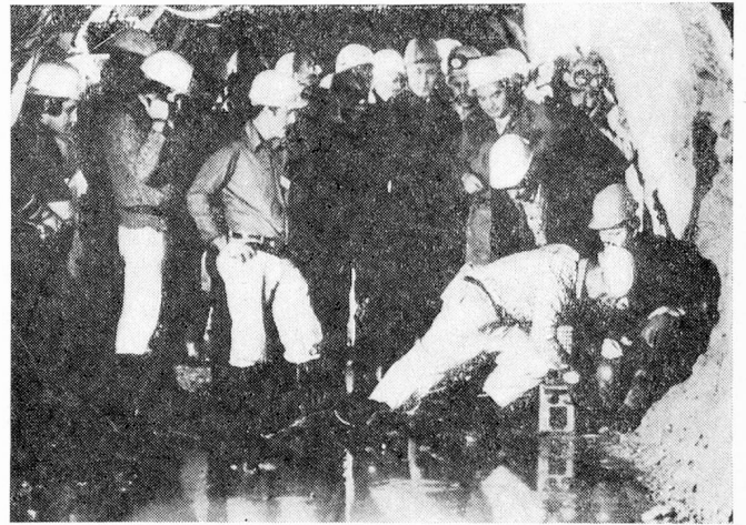
El túnel del Gotardo toma forma: aquí el dinamitado final.
