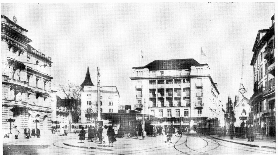
A la izq. Crédit Suisse renovado en los años del 50 y en el medio el Hotel Savoy reconstruido con elementos de la vieja fachada.
