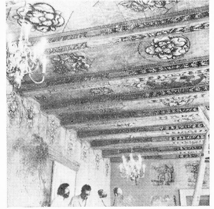
...y después de la restauración
