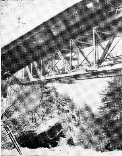
Aludes perjudicaron el tránsito en Suiza. En la línea de Lötschberg un alud causó un terrible accidente.
