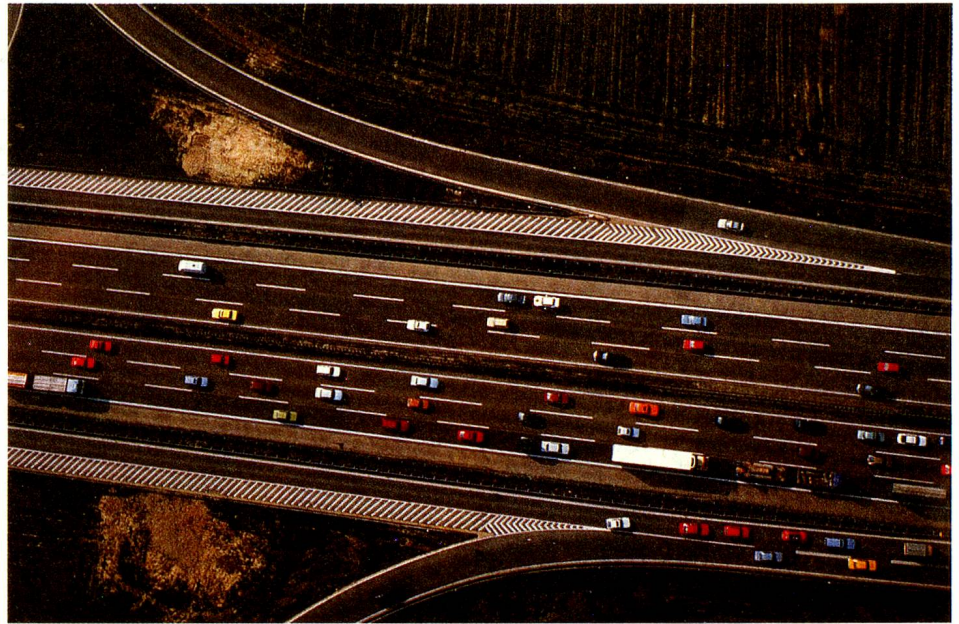
Las autopistas permiten canalizar el tráfico y presentan, por añadidura, una seguridad 5 veces mayor que las rutas principales. (Foto: Keycolor)
